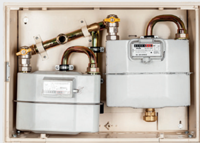
C Reduction and measurement point for 2 G6 gas meters with a spacing of 250mm Reduzier- und Messpunkt für 2 Gaszähler G6 im Abstand von 250 mm.
